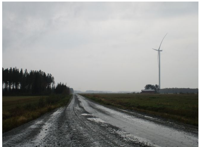
5. Kaapelireitti Nuutin pellon laidassa, lounaaseen.
