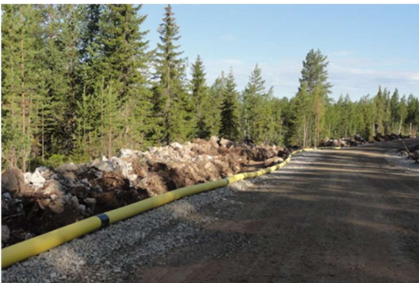
Kuva 72. Vasemmalla kuvassa on esimerkki tuulivoimapuiston rakennus- ja huoltotiestä. Teitä käytetään muun muassa betonin, soran ja voimaloiden komponenttien kuljetuksiin sekä tuulivoimapuiston käyttöväheessä huoltoajoihin. Maakaapeli sijoitetaan ojakaivantoon tien reuna-alueelle. Oikealla kuvassa tuulivoimalan osia kuljetetaan erikoiskuljetuksina. (Kuvat: FCG).
