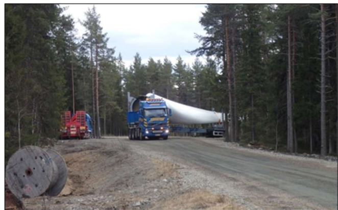
Kuva 72. Vasemmalla kuvassa on esimerkki tuulivoimapuiston rakennus- ja huoltotiestä. Teitä käytetään muun muassa betonin, soran ja voimaloiden komponenttien kuljetuksiin sekä tuulivoimapuiston käyttöväheessä huoltoajoihin. Maakaapeli sijoitetaan ojakaivantoon tien reuna-alueelle. Oikealla kuvassa tuulivoimalan osia kuljetetaan erikoiskuljetuksina. (Kuvat: FCG).
