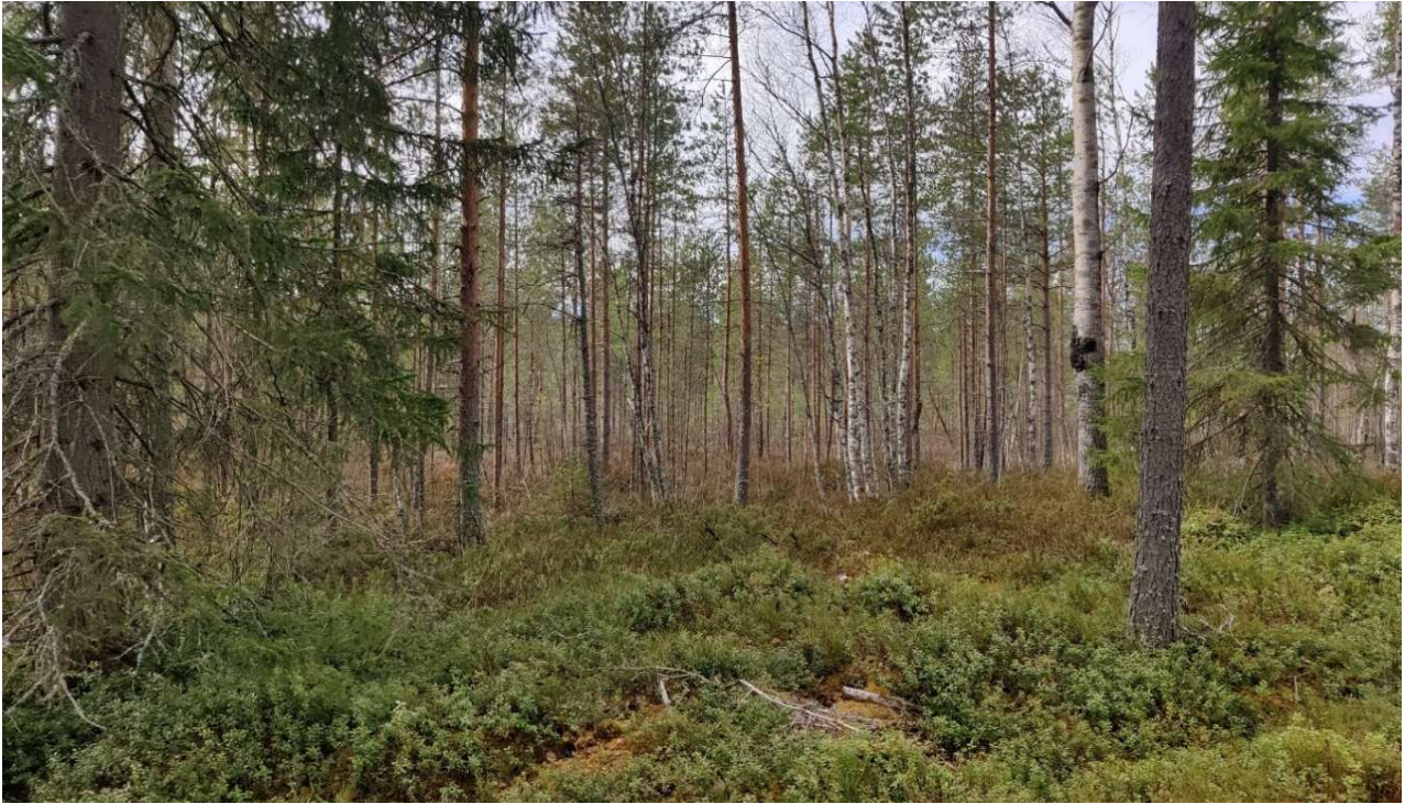
Kuva 36. Voimalan rakennuspaikkaa Veräjäkankaan pohjoispuolella Kalajoen ja Alavieskan raja-alueella. Kuivahkon kankaan ja puolukkaturvekankaan vaihettumisalueella.
